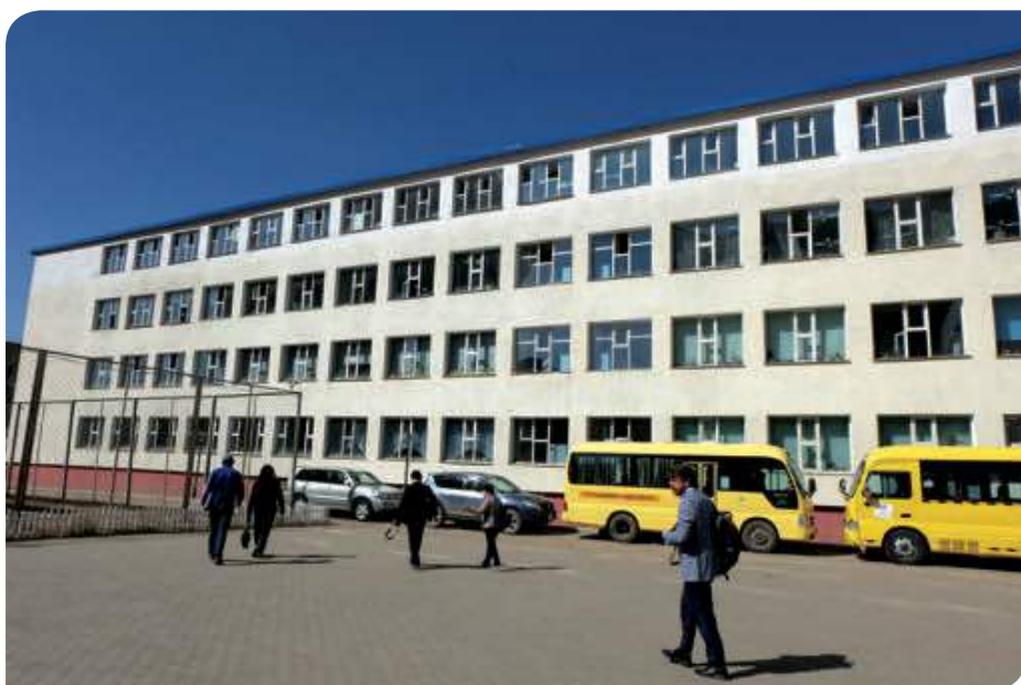
Зураг 4.2. Сургуулийн цонхыг шинэчилсэн байдал
